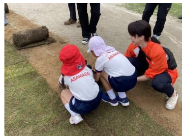
＜芝生敷設の様子＞
