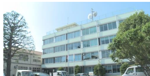
小金井市役所本庁舎
